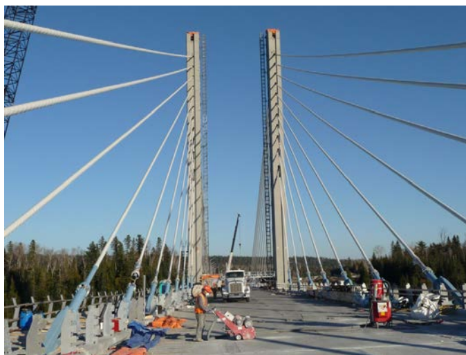
Рисунок 3 – Министерство транспорта Онтарио выбрало фибробетон для моста через реку Нипигон – 480 панелей, предотвращающих коррозию и обеспечивающих надежность и долговечность
