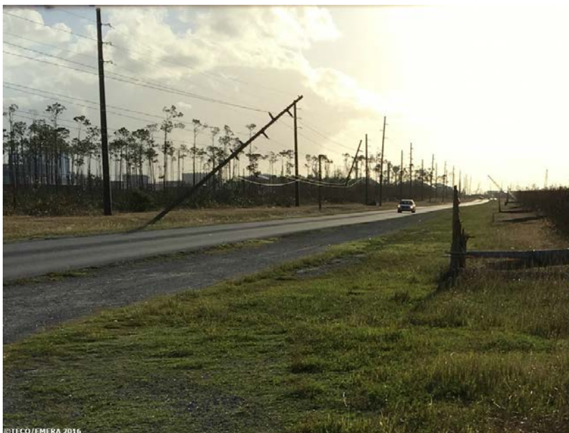
Рисунок 2 – Линия деревянных опор, построенная в 2009 году, была повреждена многочисленными ураганами. Наибольший ущерб нанес ураган Мэтью, который повалил около 2700 опор
