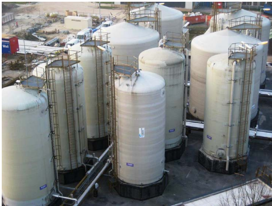
Рисунок 3. Емкости из двойного ламината для хранения серной и фосфорной кислот
