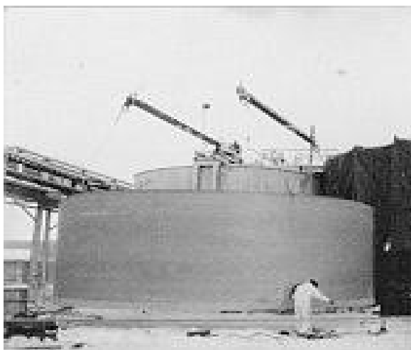
Рисунок 4. Стеклопластиковый реактор для фосфатной породы и серной кислоты
