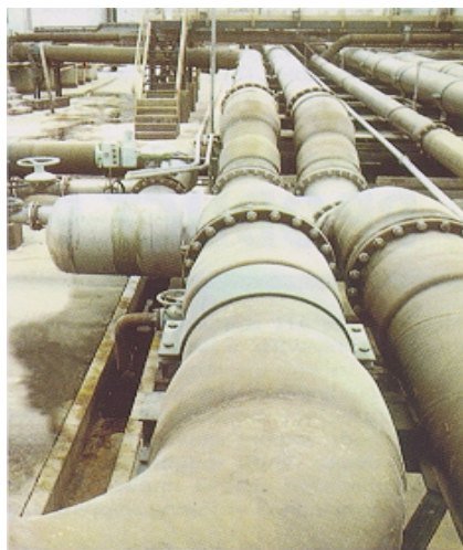
Рисунок 8. Абразивостойкие трубопроводы для пульпы
