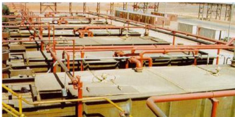
Рисунок 6. Смесители и отстойники, используемые в процессе извлечения растворителем
