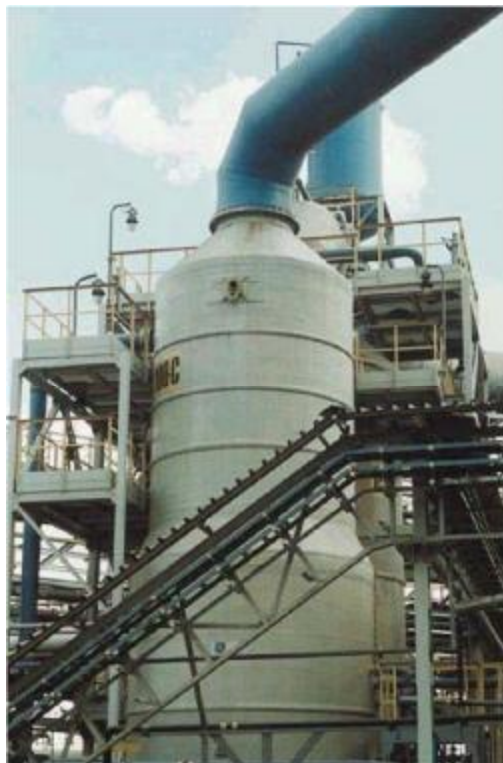
Рисунок 5. Поглотительная башня для диоксида серы
