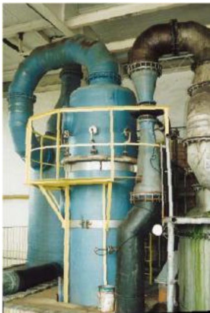
Рисунок 7. Система сбора кислого газа
