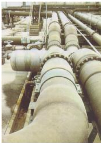
Рисунок 3. Абразивно стойкая труба для работы с коррозионно опасной пульпой
