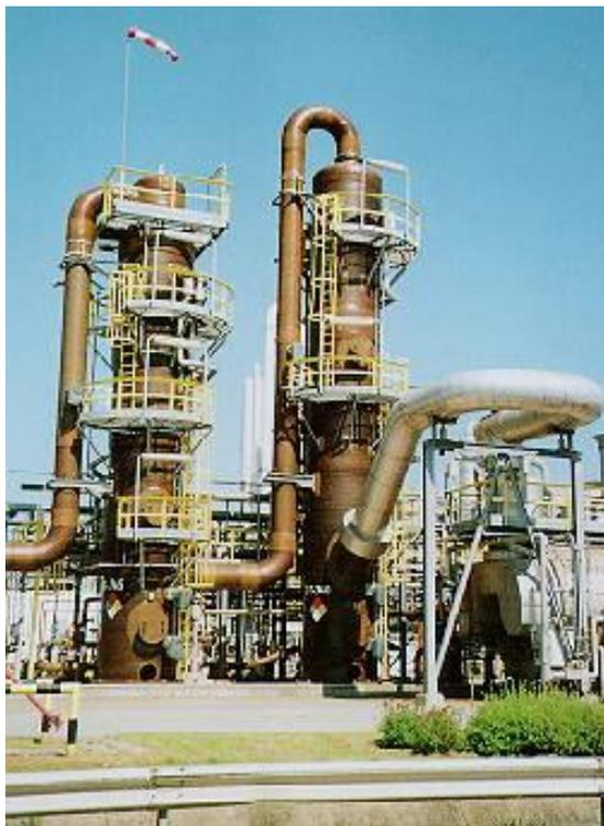
Рисунок 4: Скруббер для топочного газа (слева: нейтрализационная колонна после HCl-абсорбера), топочные газы, содержащие HCl и Cl<sub>2</sub>, очищаются с помощью NaOH / NaOCl при pH 9 и T = 65 °C, использовалась эпоксивинилэфирная смола на основе бисфенола-А, система отверждения на основе ПБ. В результате нестабильности гипохлорита через 5 лет использования возникла необходимость локального восстановления химически стойкого барьера (14).
